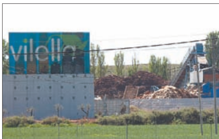
FOTO: Tony Alcántara / Imatge de com va quedar l'exterior de la planta
