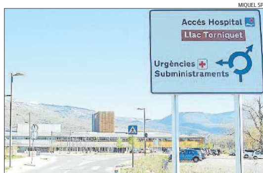
L'accés principal a l'Hospital de Cerdanya pel Pla de Rigolisa
