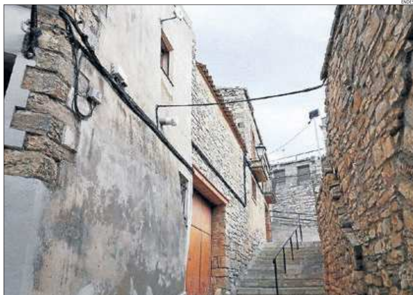
Les obres de millora que Endesa ha portat a terme a Montoliu de Segarra.
