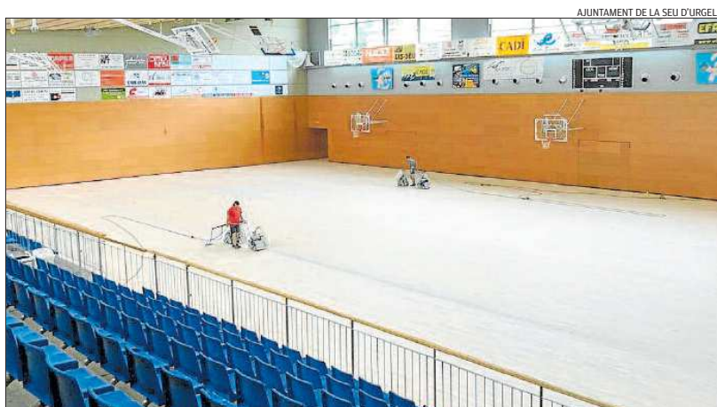
Operaris porten a terme treballs de millora del parquet del Palau d'Esports
