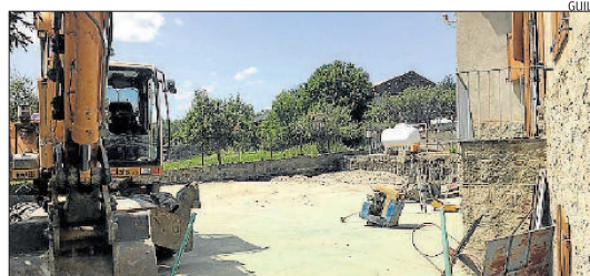
Les obres de renovació de l'antiga pista poliesportiva de Guils
