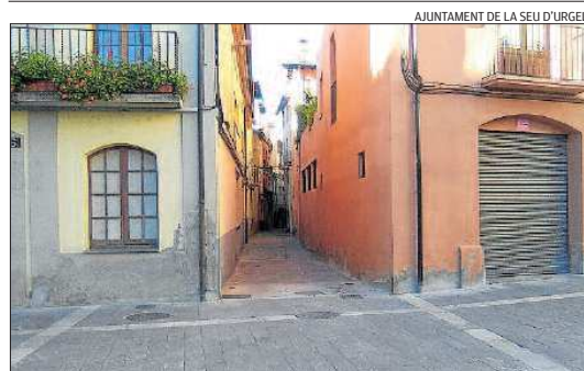
Les obres de reforma del carrer costaran gairebé 120.000 euros
