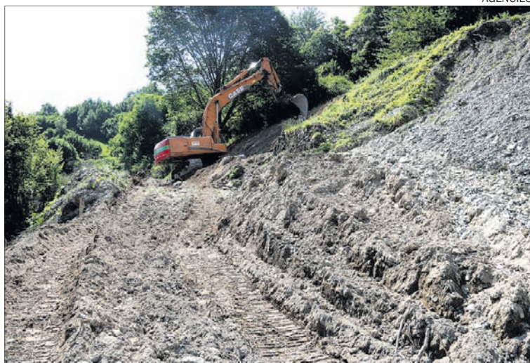
Una màquina treballant a la carretera de Baiasca.
