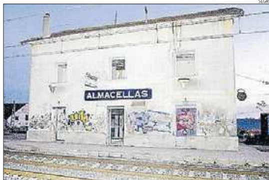
Imatge d'arxiu de l'estació de tren d'Almacelles.
