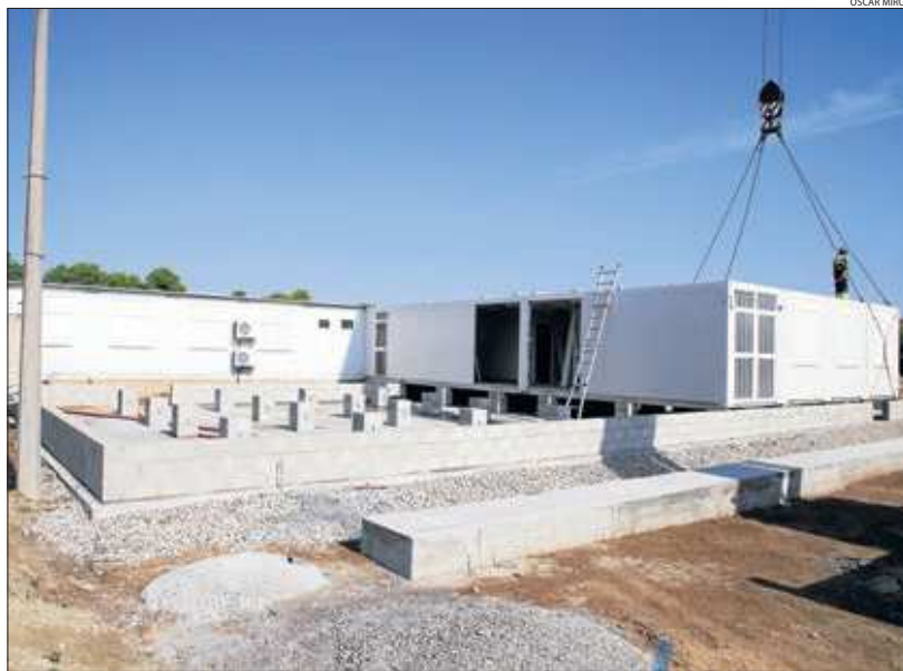
Operaris treballant en el nou institut d'Alpicat, ahir al matí.
