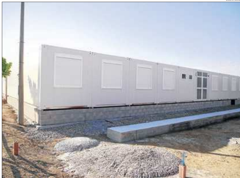
Els treballadors van acabar la instal·lació dels mòduls cap a les sis de la tarda d'ahir.
