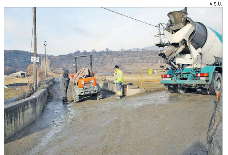
Les obres busquen millorar els accessos a les finques rústiques de la zona.
