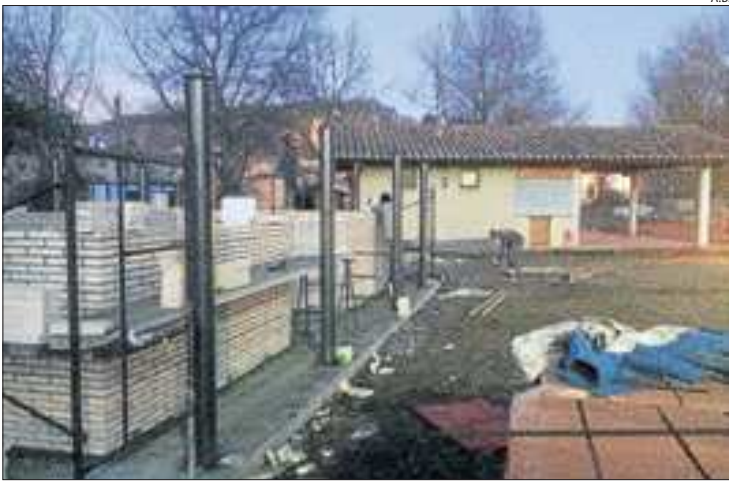
Les obres al centre de serveis de la platja d'Ogern.
