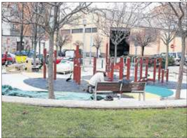
Els operaris ultimen els detalls de la instal·lació.
