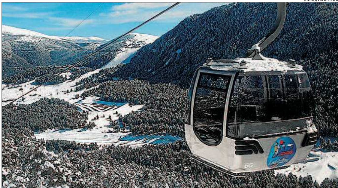
El telecabina de la Molina, un dels principals reclams de l'estació, que l'any que ve s'ha d'allargar fins a la Tosa
