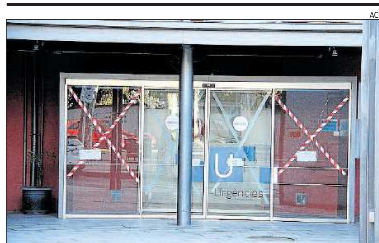
Entrada d'Urgències de l'hospital de la Seu, amb proteccions als vidres
