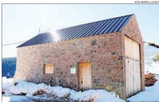
Imatge de l'edifici de Rubió, on s'ubicarà el centre.
