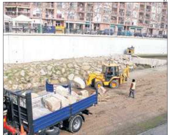
Els operaris treballen durant aquesta setmana en el nou mur.
