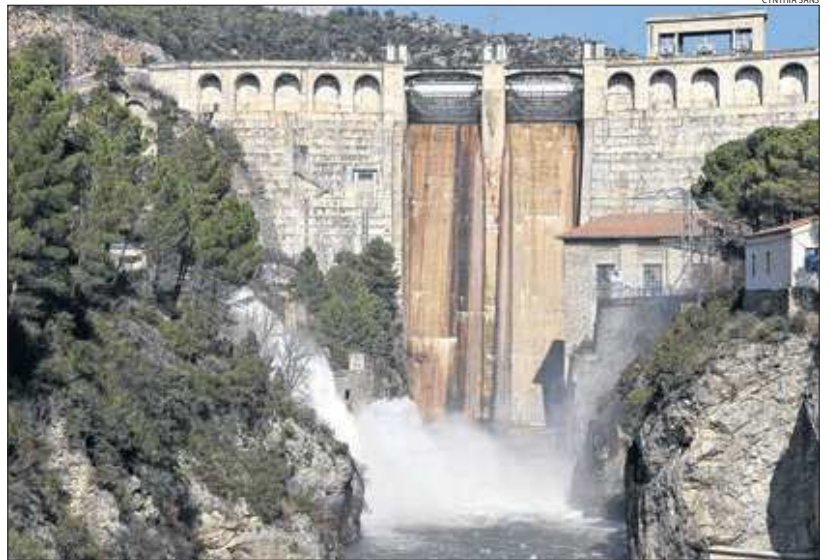
La presa d'Oliana, inspeccionada amb la de Rialb, i l'aigua sortint de la canonada lateral.
