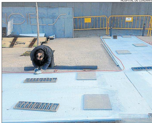
Un operari instal·lant el terra calefactat a l'accés d'Urgències
