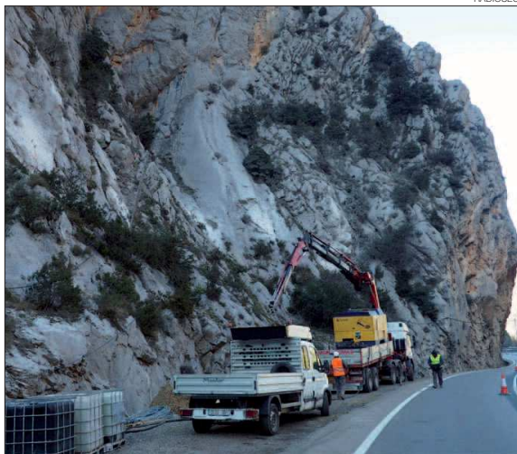
► Els camions que estan duent a terme la col·locació de les malles.
