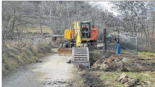
Les obres de construcció del mur al camí d'Estaó de la Seu d'Urgell
