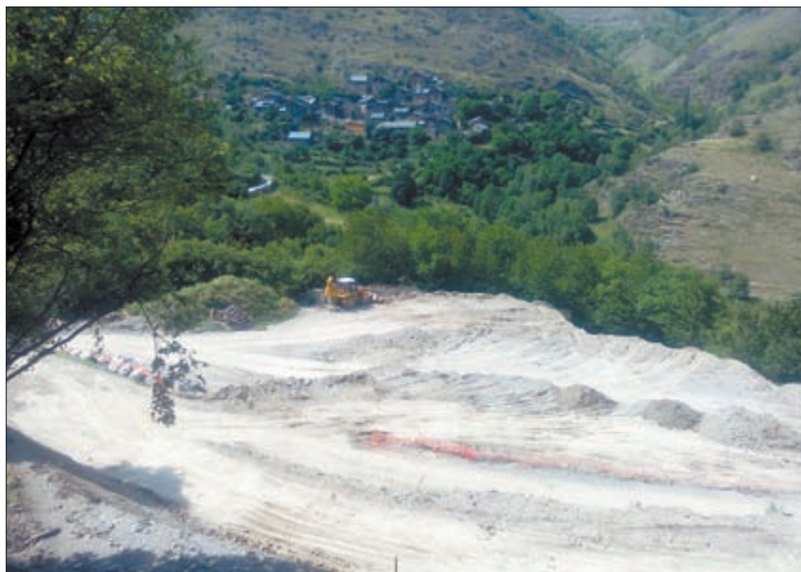
FOTO: EMD Baiasca / Les obres del nou accés estan ara en plena execució. Al fons, el poble de Baiasca
