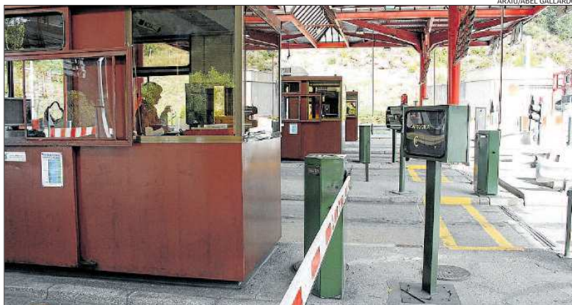
Peatge de Túnel del Cadí, que per error ha estat cobrant durant dos dies als abonats cerdans
