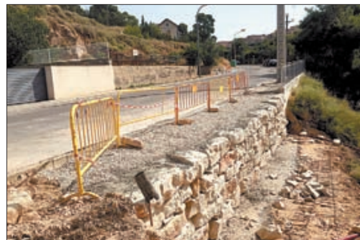
FOTO: La Paeria / Les obres de la vorera duraran uns dos mesos
