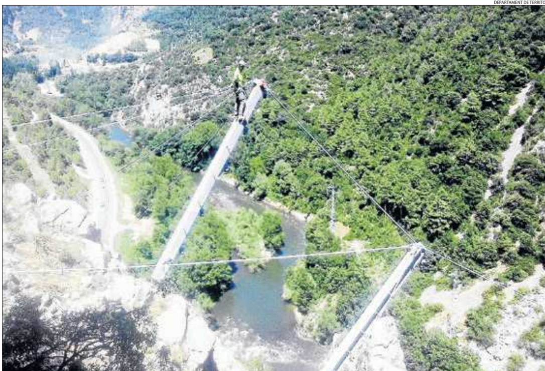
Un operari instal·lant pantalles dinàmiques per evitar la caiguda de roques a la C-14 entre Organyà i Montant de Tost.
