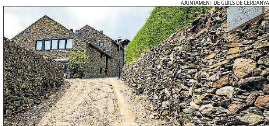
Les obres de reurbanització del carrer de Catalunya, al centre de Guils
