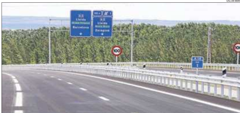
L'autovia A-14 és a punt per obrir una vegada instal·lada la senyalització vertical i horitzontal.
