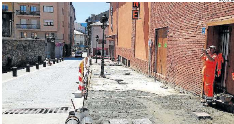
Operaris en la remodelació del tram superior del carrer Major en la cruïlla amb la rambla de Josep Maria Martí
