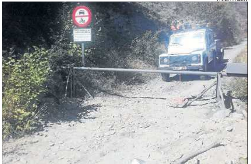
Una de les barreres basculants instal·lada en una pista forestal de l'EMD de Baiasca, a Llavorsí.
