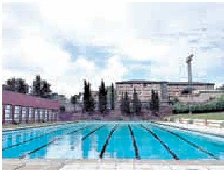
FOTO: Aj. de Solsona / Les obres han suposat una millora de les instal·lacions
