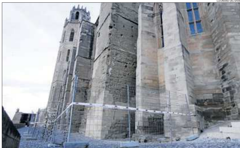
Les tanques de protecció van ser instal·lades ahir a la Seu Vella per evitar possibles danys.
