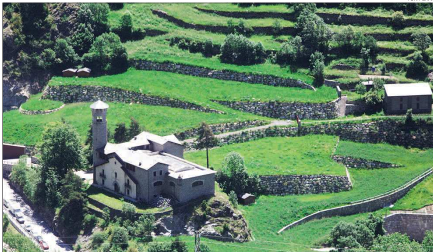
► Una imatge general de l'edifici de Radio Andorra, a Encamp.
