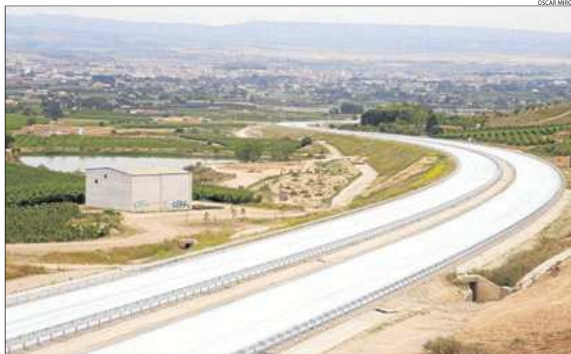
Les calçades de l'A-14 a Torrefarrera, blanques per una nova tècnica per a l'asfaltatge.
