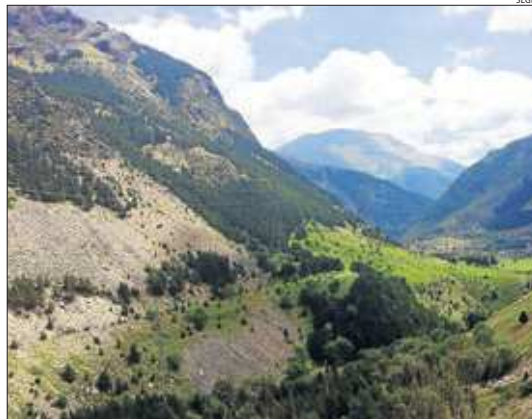
Línies elèctriques a la Torre de Capdella.
