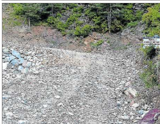
A dalt, la pista després de la torrentada. A baix, ja reparada
