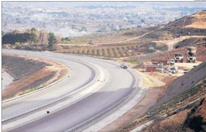
Les obres al tram de Lleida a Rosselló pendents de l'últim asfaltatge i que es preveu obrir al maig.
