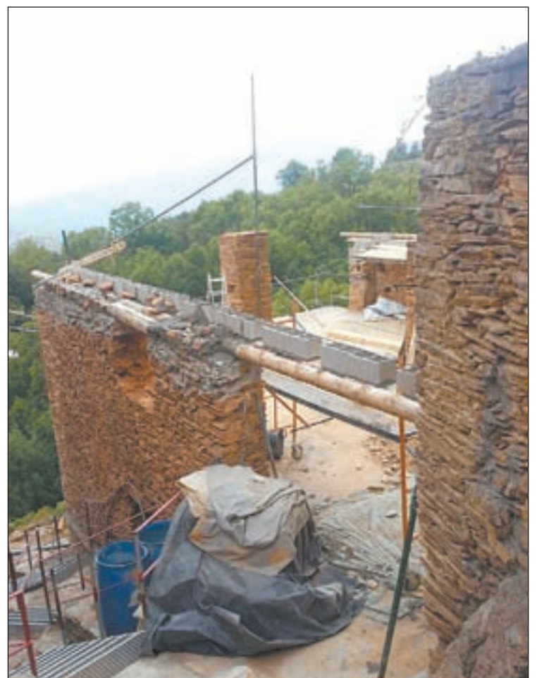
FOTO: Saül Garreta / Imatge de la construcció del refugi
