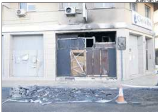
Les flames van afectar un local abandonat i precintat.
