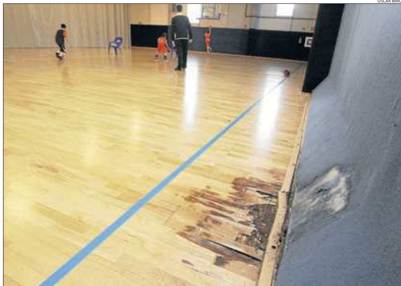
Una de les zones del parquet amb la fusta i la moqueta podrida per culpa de les goteres.
