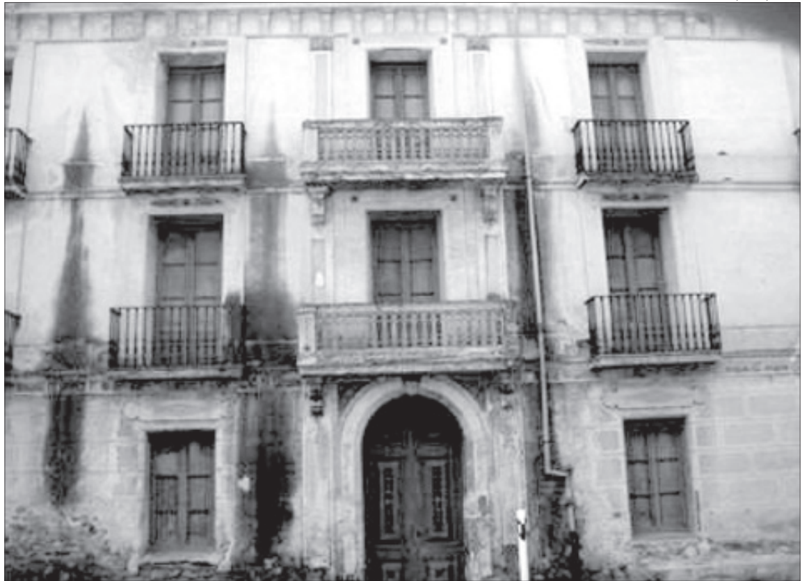
La casa nova dels Banys de Sant Vicenç, que va servir com a hospital de campanya i on van morir dos centenars de soldats.
