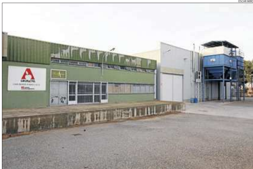
Imatge presa dimecres de l'exterior de la Cooperativa d'Arbeca.
