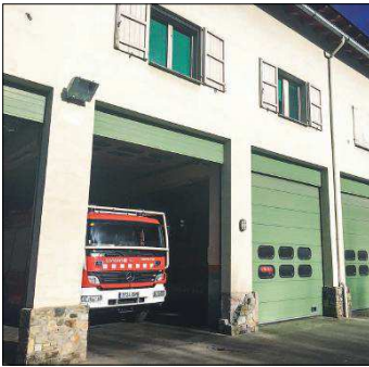
► Les instal·lacions del parc de Bombers.
