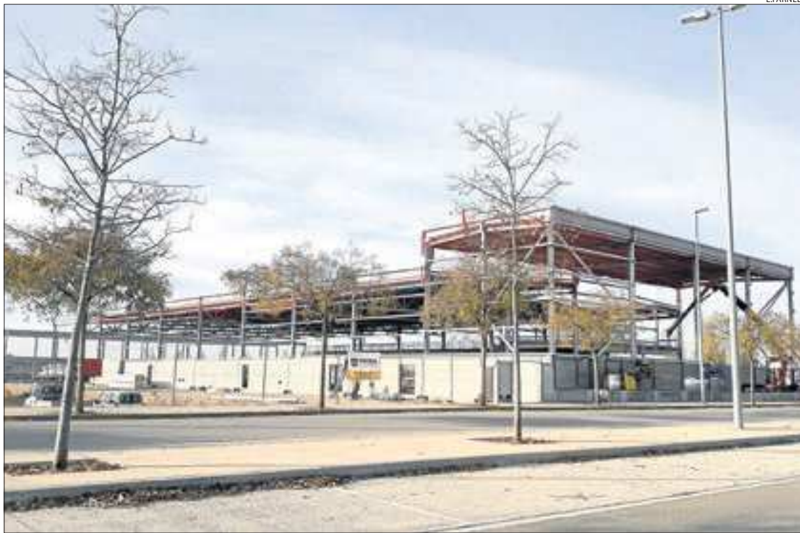
Imatge de la construcció de l'obra del grup Teresa Carles al polígon industrial Vinyes del Mig.
