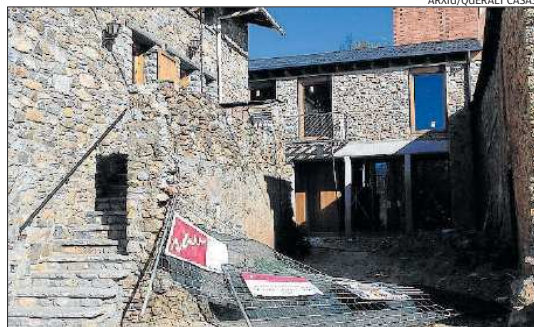
El nou edifici consistorial enllestit darrere l'actual, que s'enderrocarà
