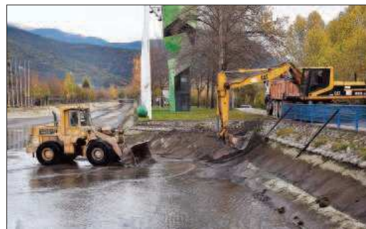
Una màquina retirant fang ahir al migdia.
