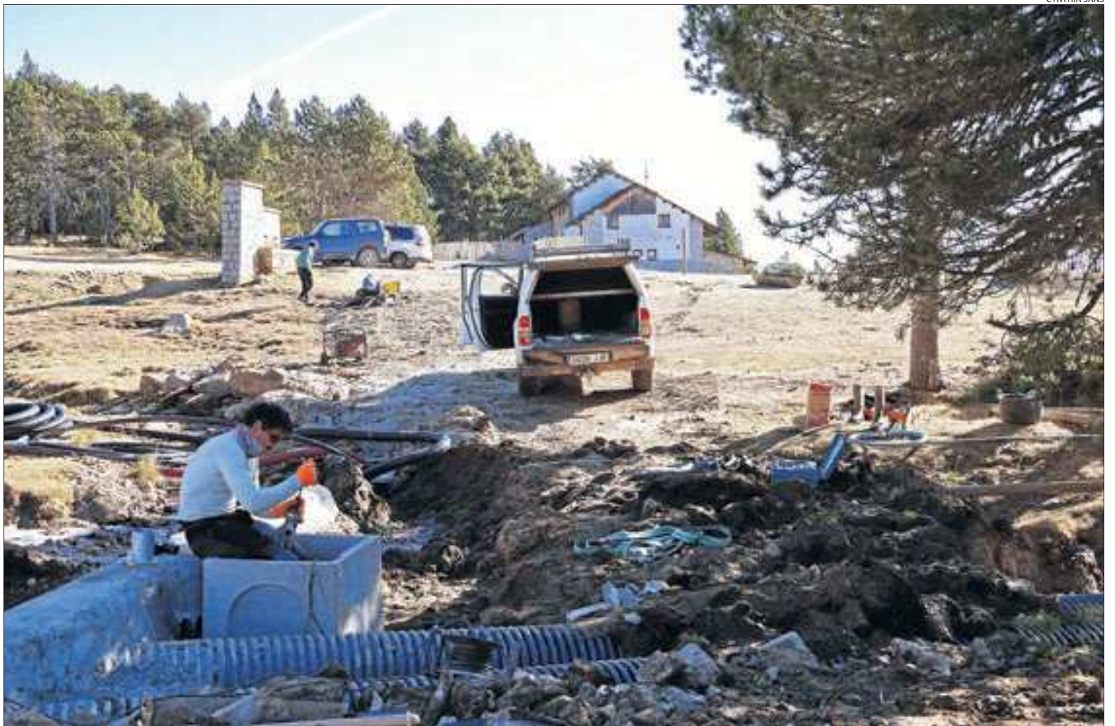
Obres per a una nova captació d'aigua per produir neu a Lles de Cerdanya, en una zona davant del refugi de muntanya.
