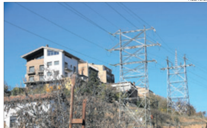
Imatge de la línia que passa a poca distància de les cases de Tremp.
