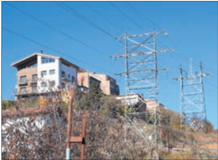
FOTO: Marta Lluich (ACN) / Imatge de torres elèctriques a Trepmp
