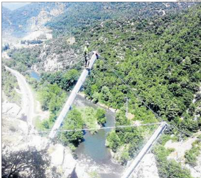
Un operari instal·lant pantalles per evitar la caiguda de roques a la C-14 el mes de juliol passat.
