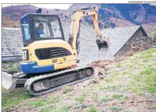
Una excavadora treballant en la retirada de runa a Bausen.
