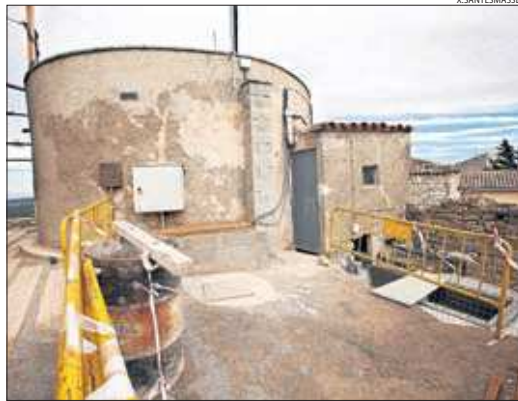
Imatge d'unes obres al dipòsit de l'Ametlla de Segarra.
