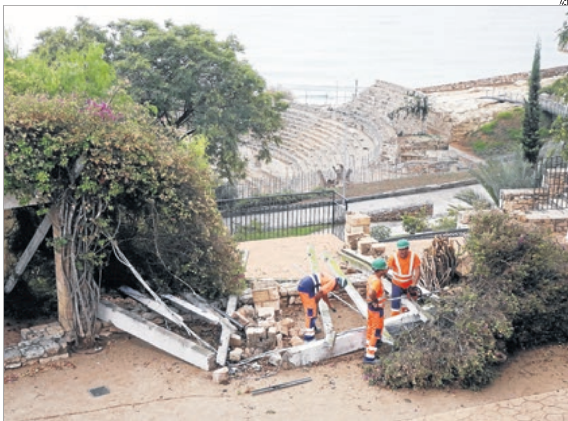
Operaris treballen a Tarragona per arreglar les destrosses del temporal de les últimes hores.
