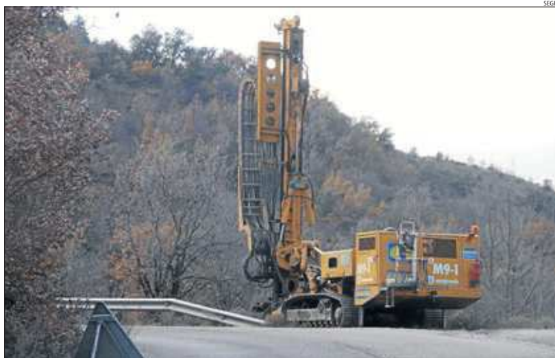
Imatge d'arxiu de màquines a l'accés a Port Ainé, que centra de nou una part de la inversió.
