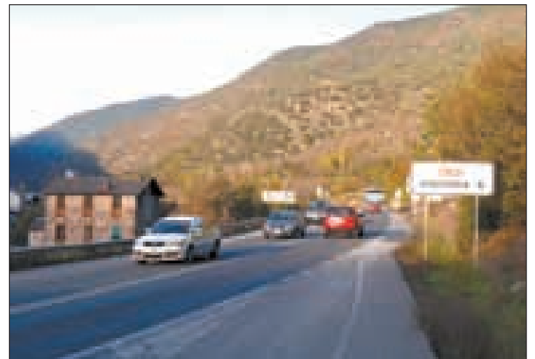
FOTO: ACN / L'N-145 es millorarà de la Seu fins a la frontera andorrana
