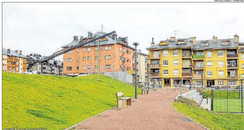
El parc dels Quatre Camins de Puigcerdà, on l'Ajuntament té previst instal·lar el primer punt de càrrega
