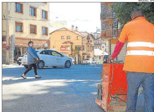
Un operari talla l'asfalt de la plaça per començar a retirar-lo
