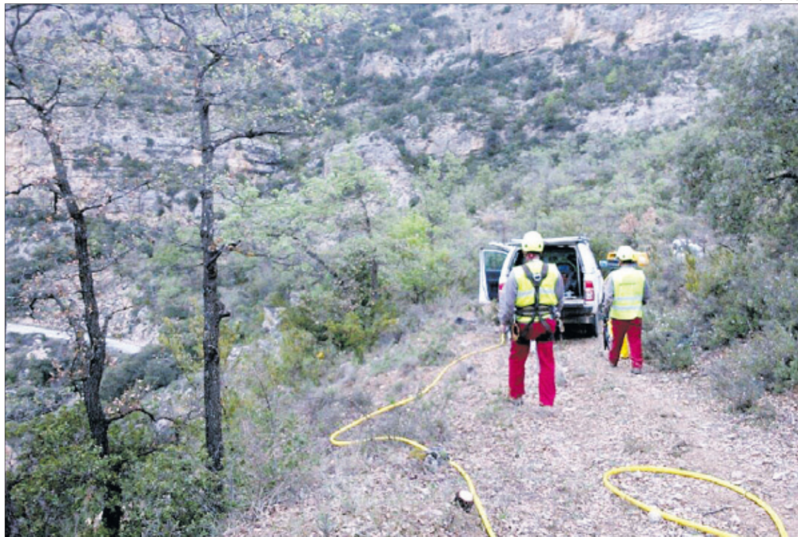
Operaris treballant ahir a la zona de l'esllavissada de Castell de Mur.
