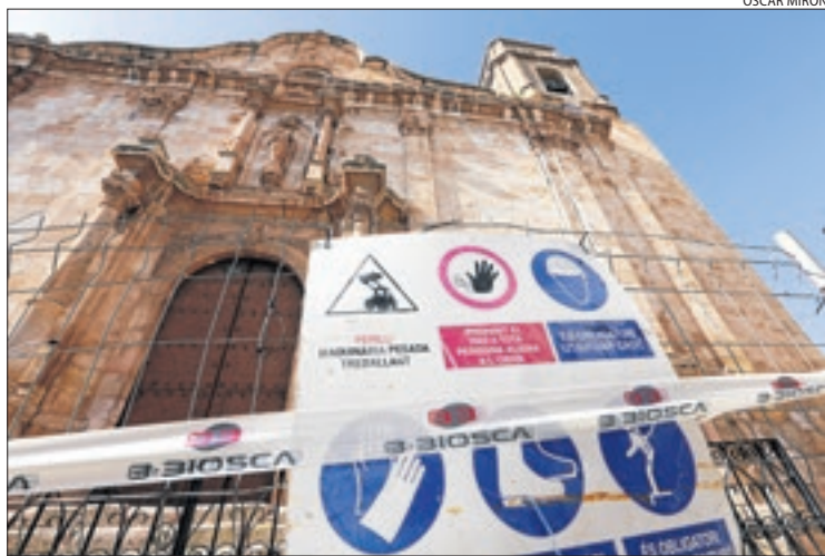
L'església d'Algerri espera que s'iniciïn els treballs.
