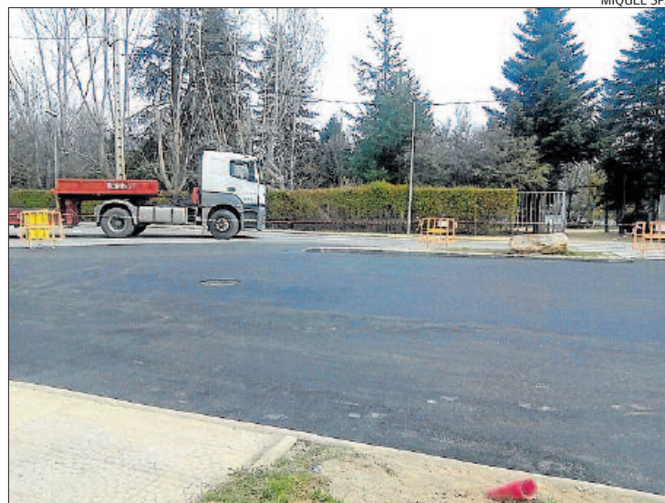
L'aparcament situat al costat de l'accés nord del parc Shierbeck, al fons
