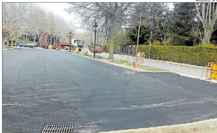
La nova capa d'asfalt, que ja dóna un nou aspecte a l'antic solar
