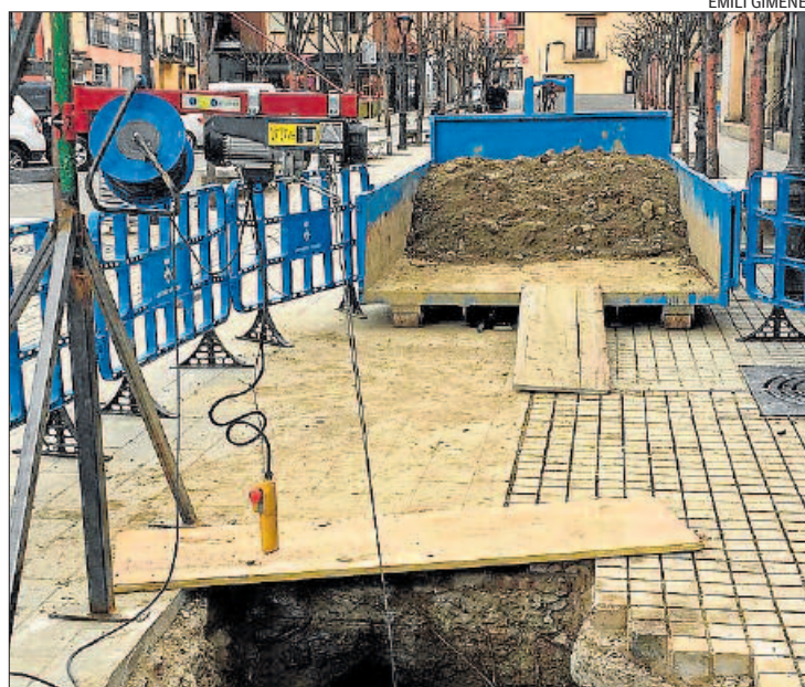
El forat fet ara al Passeig que servirà de ventilació al túnel visitable
